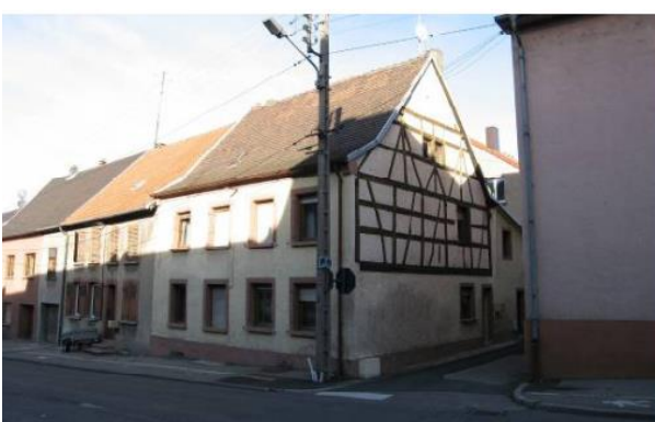
Maison à colombage, rue de Grosliederstroff à Welfering
