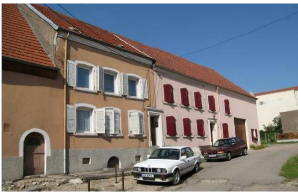
Fermes du XVIII ème et XIX ème siècles, rue de Deux-Ponts à Neunkirch
