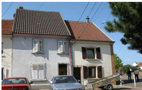
Petites maisons d'ouvriers agricoles, rue de l'Eglise à Neunkirch
