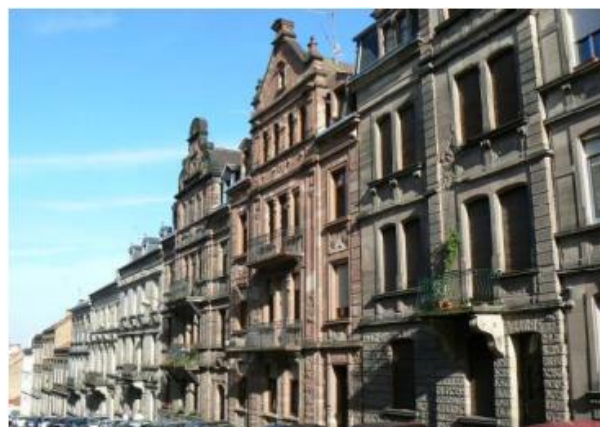
Immeubles de la rue du Parc, dans un style allemand
