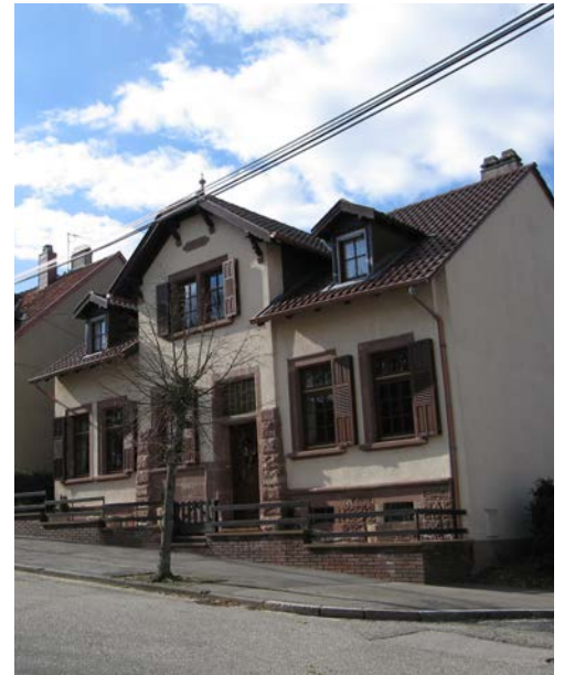
n°47 rue de Hambach
