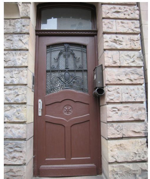
n°39 rue du Parc : détails de menuiserie
