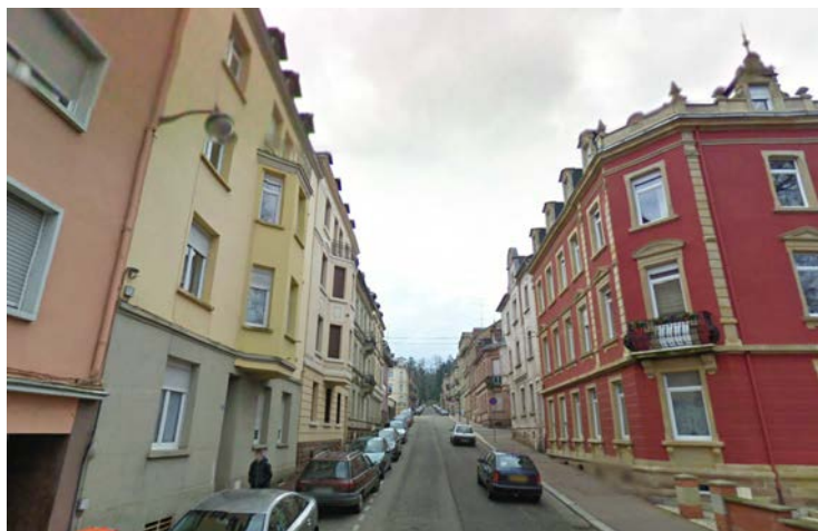
La rue du Parc, jusqu'à la rue du Lycée (n°1 à 22) : les immeubles répertoriés dans cette rue (surtout côté Nord vers la rue du Lycée et la rue Pauline), sont soit des immeubles aux façades enduites, soit en pierre de taille apparente.
