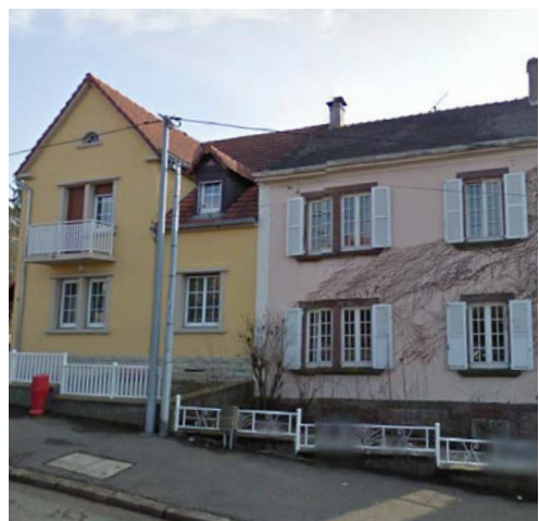
n°8-10 rue des Tirailleurs
