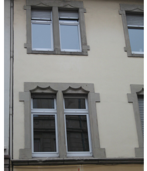
n°23 rue du Lycée : détails de baies
