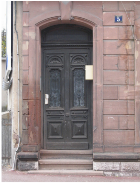
détails de menuiserie : porte d'entrée n°5
