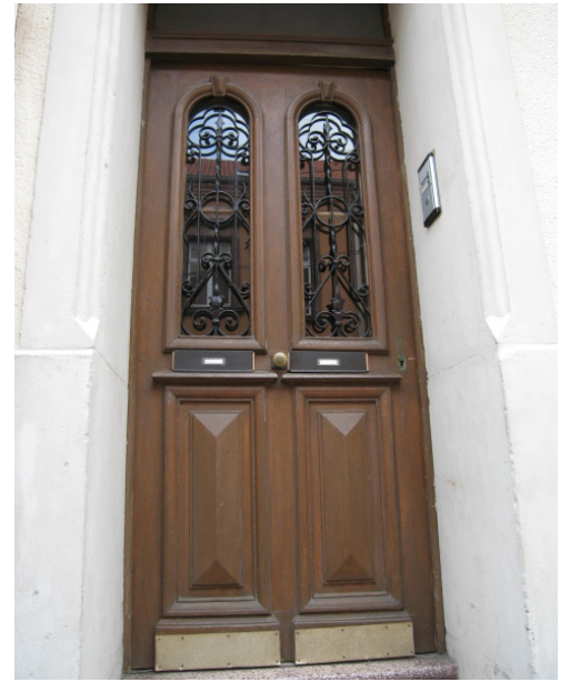
détails de menuiserie : porte d'entrée n°15
