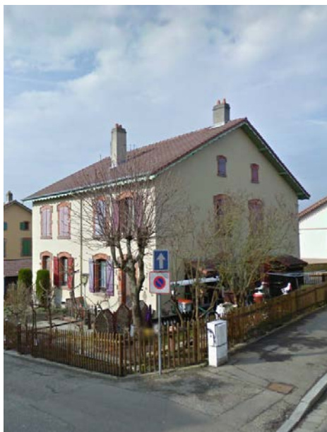
n°14-16 Cité 2 e Avenue (arrière n°13-15 Cité 1 ère )
