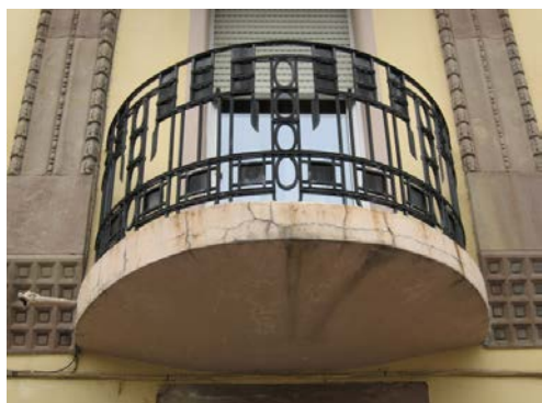
modénature : balcon & garde-corps
