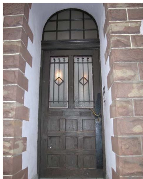
n°41 rue du Maréchal Foch, détails de porte
