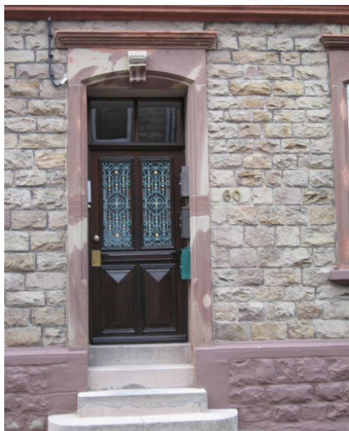
n°60 rue du Petit-Paris : détails de menuiserie
