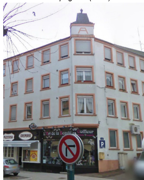
n°1 rue du Château* (modénature supprimée)
