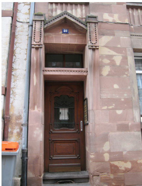
n°40 rue du Parc : détails de menuiserie
