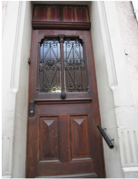
détails de menuiserie : porte d'entrée n°13
