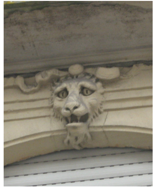
n°22 rue du Parc : détails de modénature
