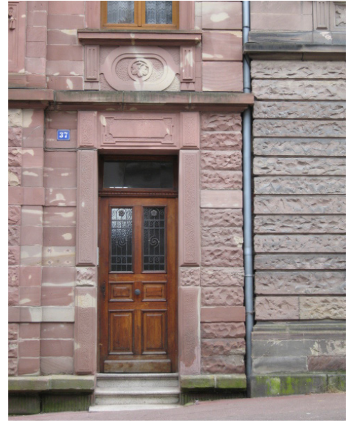
n°37 rue du Parc : détails de menuiserie
