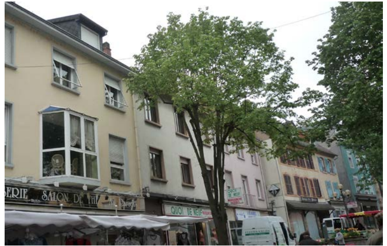
Rue de l'Eglise, n°10 à 18 : ces maisons de la Reconstruction sont de taille plus modeste que les autres grands immeubles de la rue construits à la même période.
