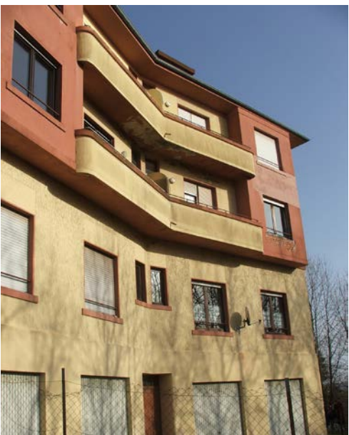
n°31 rue du Blauberg, détails de façade
