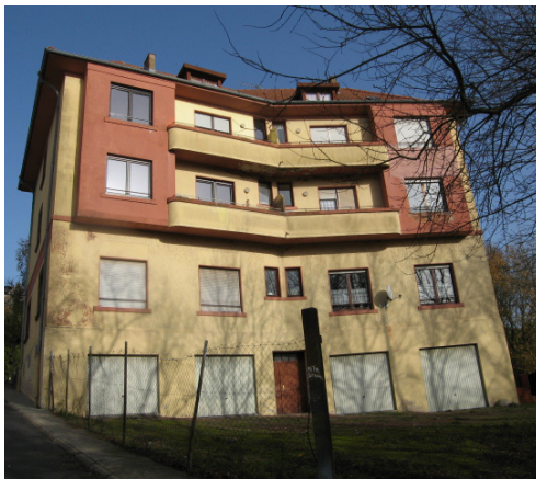
n°31 rue du Blauberg, façade arrière
