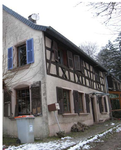
n°2 rue de l'Egalité, façade avant
