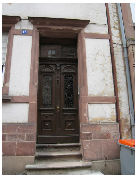
détails de menuiserie : porte d'entrée n°42
