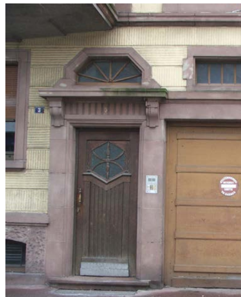
n°3 rue J. Jaurès, détails de modénature et de porte
