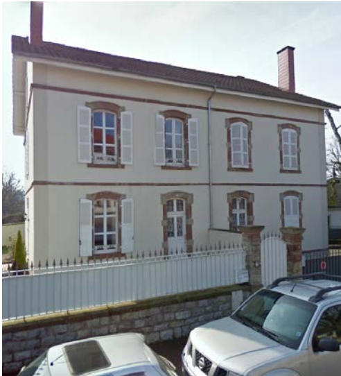
n°8-10 rue de la Cité
