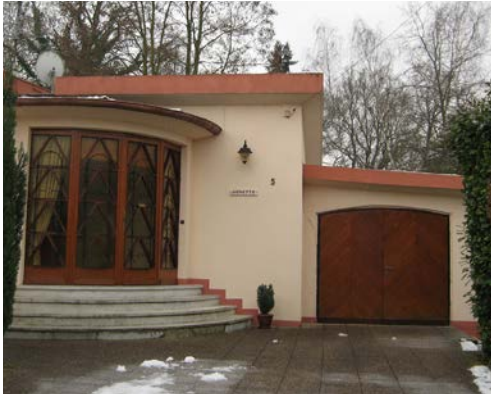
n°5 rue Joseph : détails de menuiseries
