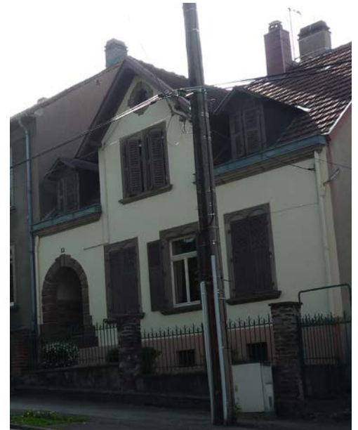
n°49 rue de Hambach
