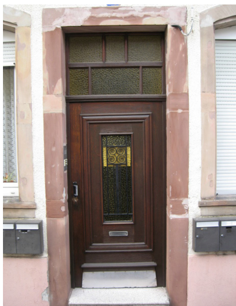
détails de menuiserie : porte d'entrée n°40
