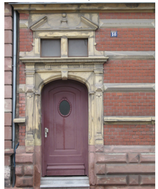
n°18 rue du Parc : détails de menuiserie
