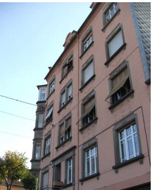
détails des baies
