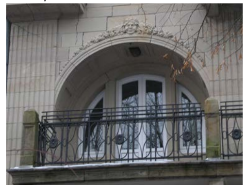
détails : loggia avec balcon
