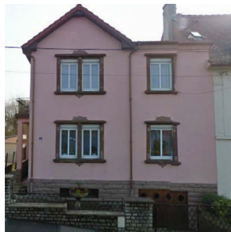
n°6 rue des Tirailleurs
