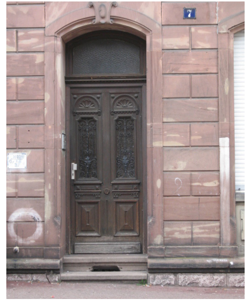
détails de menuiserie : porte d'entrée n°7
