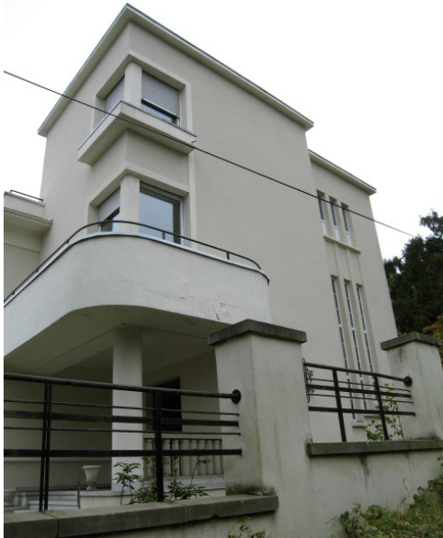
détails des baies
