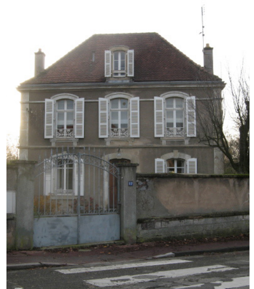
n°12 rue de la Cité
