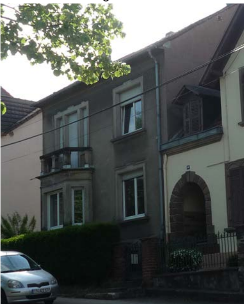
n°51 rue de Hambach
