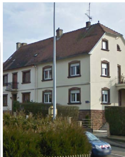
n°2-4 rue des Tirailleurs
