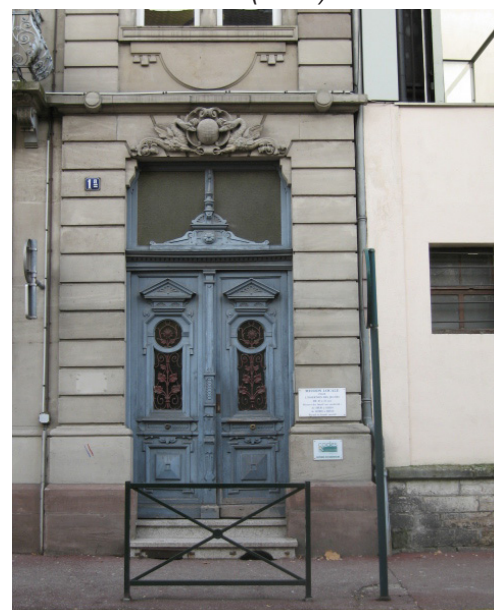
n°1A rue de la Cité, détails de porte
