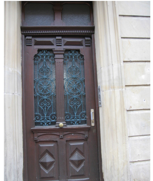
n°28 rue du Parc : détails de menuiserie
