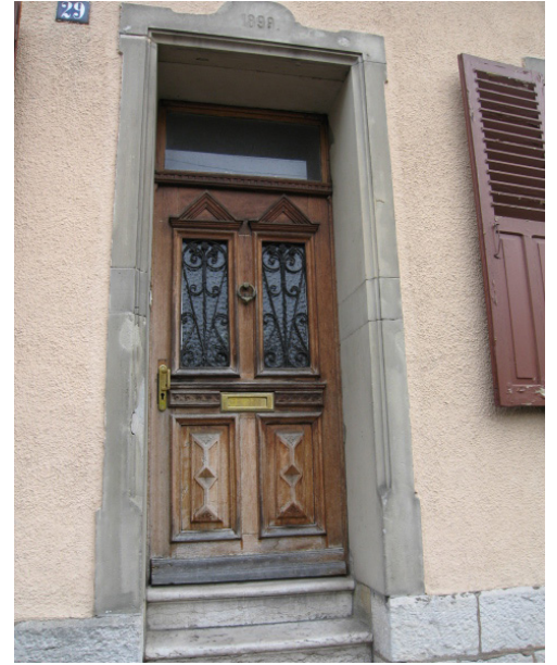
n°29 rue du Petit-Paris : détails de menuiserie
