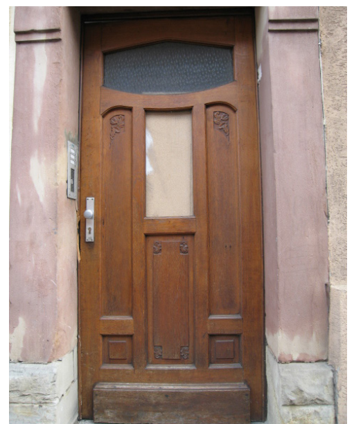
détails de menuiserie : porte d'entrée n°39
