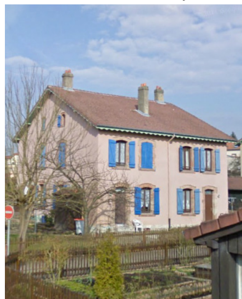
n°2-4 Cité 2 e Avenue (arrière n°1-3 Cité 1 ère )
