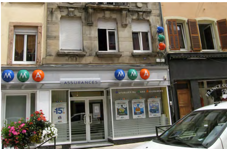
n°12 rue de Verdun : nombreux rez-de-chaussée de ces immeubles ont été complètement transformés ou démolis dans la seconde moitié du XX e siècle pour y installer les devantures commerciales.
