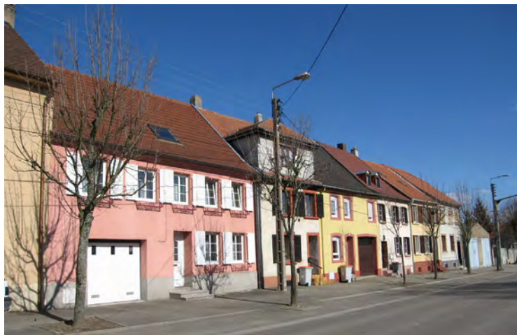
n°10-12-14-16-18 rue d'Ippling : plusieurs façades ont été modifiées (isolation extérieure, suppression des encadrements en pierre, enduit monocouche, remplacement des menuiseries).
