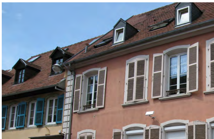
n°12-10 rue d'Or : couvertures en tuiles plates (biberschwanz), lucarnes en bâtières en partie basse.
