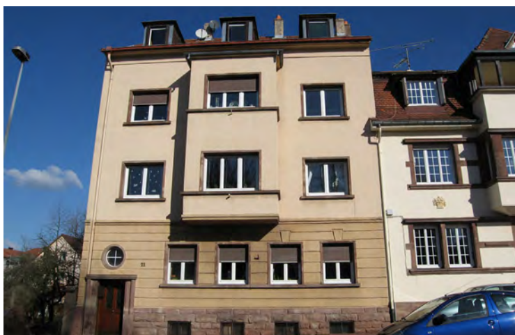
n°21 rue du Général Mangin (type E2)
