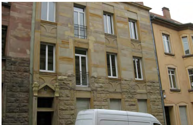
n°36 rue du Parc
