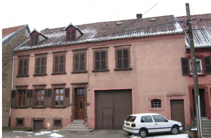
n°28 rue de Bitche : les encadrements des baies et de la porte d'entrée sont réalisés en grès rose (légèrement bigarré), laissés naturels, les autres ainsi que le soubassement sont peints.
