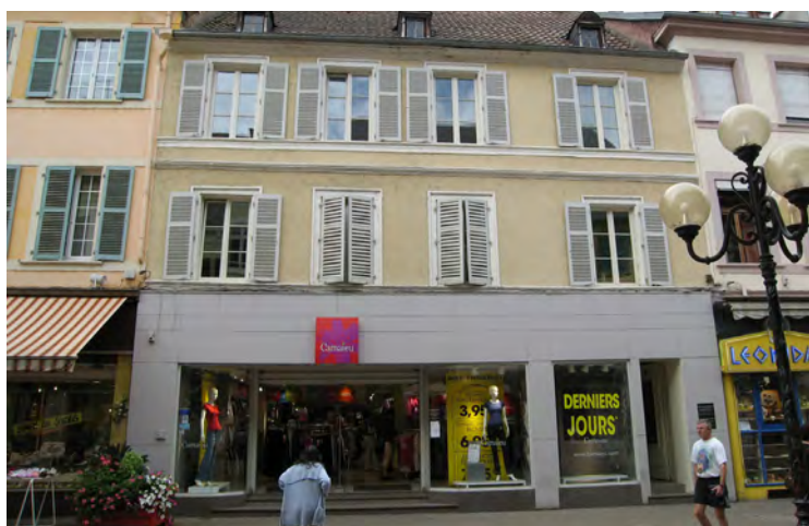
n°9 rue Sainte-Croix (devanture en applique contemporaine) : la seconde entrée permettant d'accéder aux étages a été conservée et l'éclairage des vitrines se fait pas l'intérieur. Il manque une rampe PMR (obligation d'accessibilité d'ici 2015).
