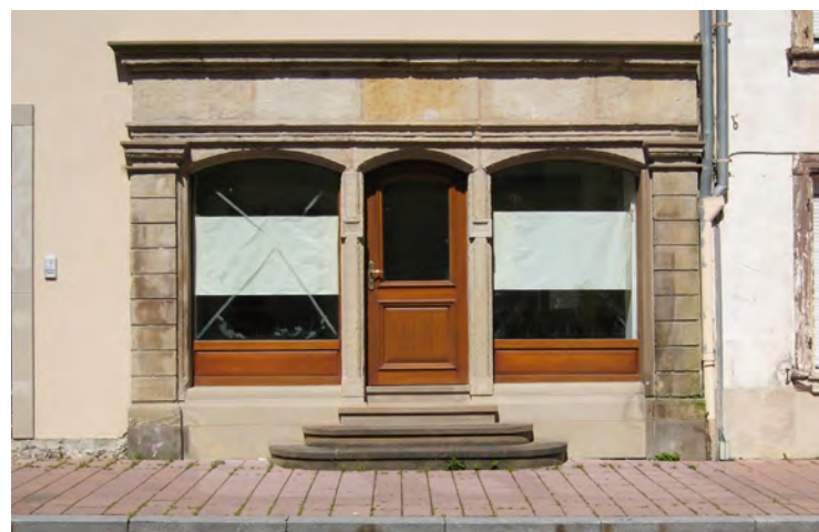
n°11 rue de la Paix : rare devanture du XIX e siècle qui a parfaitement conservé son aspect originel (démolition-reconstruction de l'immeuble avec conservation et reconstruction partielle de la devanture d'origine).
