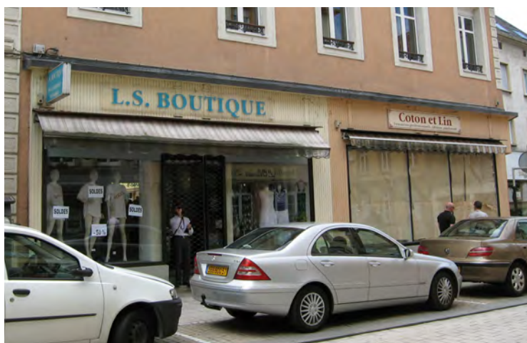
RDC avec devanture commerciale au n°6 rue du Marché : de nombreux rez-de-chaussée de ces immeubles ont été complètement transformés ou démolis par l'installation de commerces.
