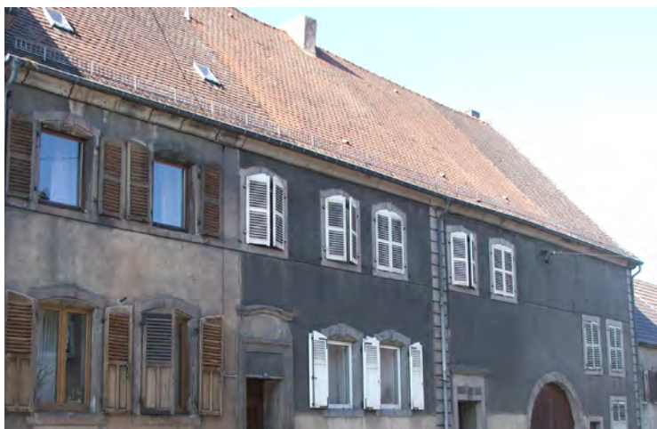
n°14 rue de Grosbliederstroff : exemple de toiture traditionnelle couverte de tuiles plates (biberschwanz).
