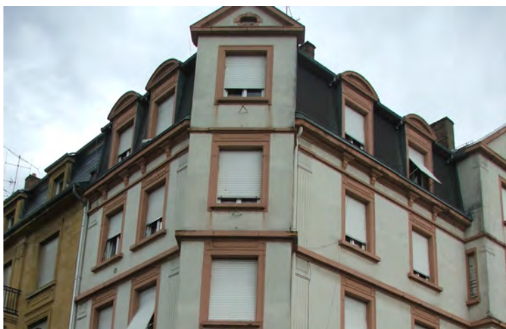
n°1 place de la Gare
