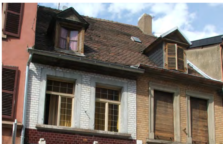
n°22-24 rue de France : les éléments qui ne sont pas d'origine sont les appuis et encadrements des baies en béton, les façades en briques.
