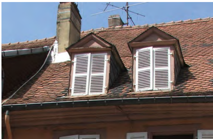
n°16 rue d'Or (type A1) : lucarnes en bâtière traditionnelles (hauteur du fronton équivalent à la moitié de la hauteur de la fenêtre, fronton en bois à panneau mouluré, couvert de tuiles plates biberschwanz, jouées en ardoises,)
