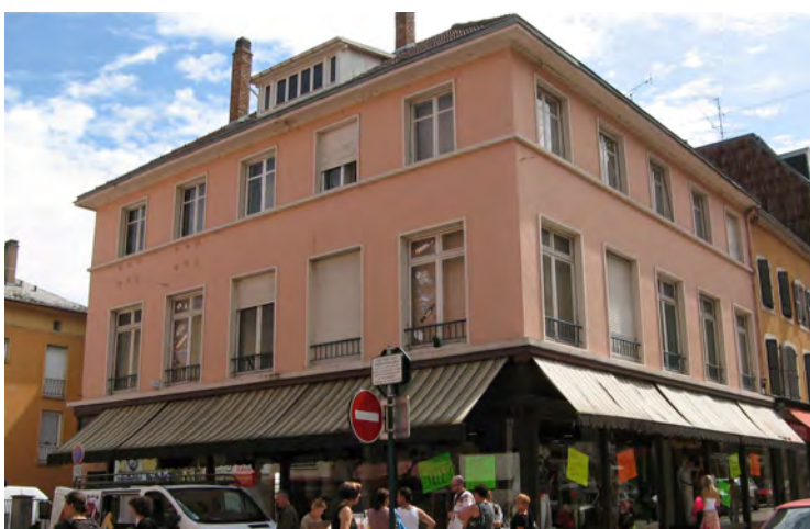
n°20 rue de l'Eglise : les baies conservent encore un format vertical mais le plus souvent celles-ci sont de format carré ou horizontal.
