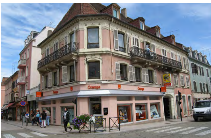
n°1 rue Charles Utzschneider : grand linéaire de façade, aux travées très régulières et ordonnancées, limitées à R+2. La pierre de taille utilisée est du grès gris-beige qui a été peint en beige clair.
