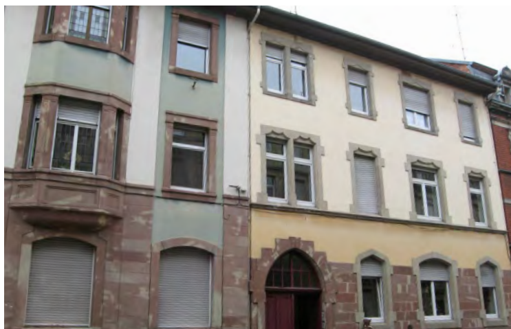
n°23 rue du Lycée (type D1) : encadrements des baies avec linteaux en double accolade en pierre gris-beige, soubassement et trumeaux des baies du rez-de-chaussée en grès rose.
