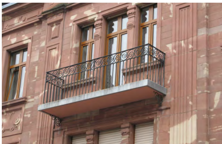
n°37 rue du Parc
