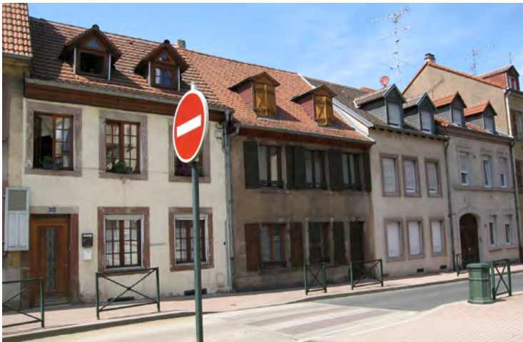
n°24-22-20-18 rue du Bac (type B1) : alignement de toitures à 2 pans, couvertes de tuiles biberschwanz avec lucarnes (modèles en bâtière). La plupart de ces maisons possèdent des volets roulants.
