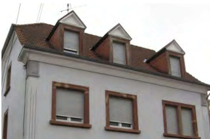
n°11 rue Lamartine : toit à 2 pans avec demi-croupes et faîtage parallèle à la rue, recouvert de tuiles mécanique à double côtes. Les jouées des lucarnes sont recouvertes d'ardoises en écailles rouges posées à la schuppen (à la "vieille allemande").
