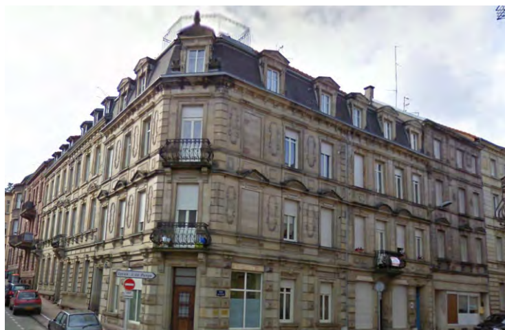
n°24 rue du Parc
