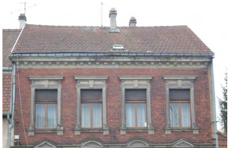
n°17 rue du Bac (1910)
