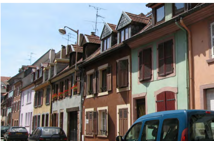
n°16-24 rue d'Or (type A1) : les façades sont très colorées, avec des encadrements en pierre également peints. Ces couleurs vives ou pastels ont été réalisées au début du XX e siècle, à l'origine les enduits étaient de couleur sable.
