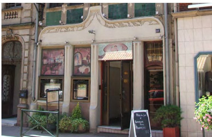
n°11 rue des Généraux Crémer (devanture avec encadrements en pierre)
