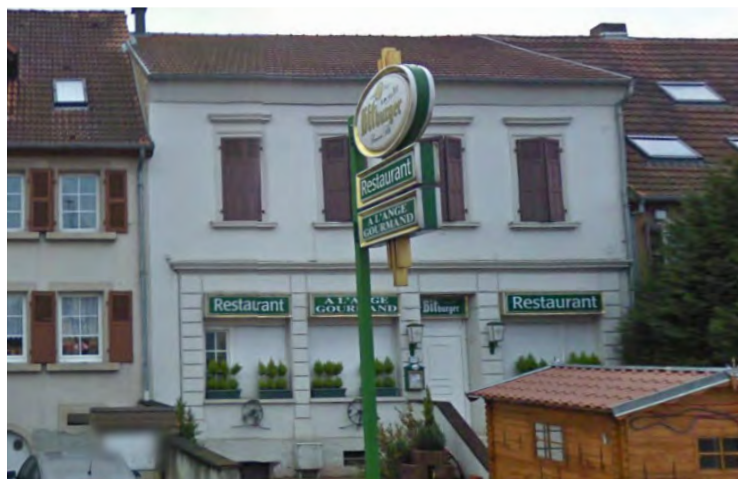
n°136 rue Foch : tous les éléments de modénature ont été réalisés en pierres de taille malencontreusement peintes.
