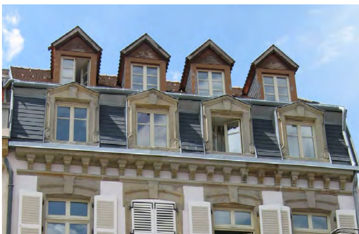
n°15 place du Marché : couverture sur brisis en ardoises rectangulaires posées à la française et lucarnes frontons. Couverture en tuiles plates (biberschwanz) traditionnelle sur terrasson avec lucarnes en bâtières.
