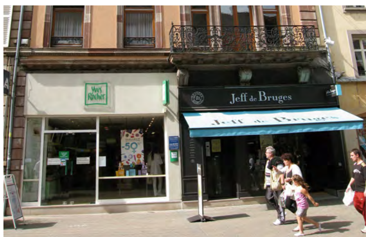
n°1 rue Sainte-Croix : le commerce de droite a réalisé une devanture en applique traditionnelle qualitative avec rampe PMR, ce qui n'est pas le cas du commerce de gauche.
