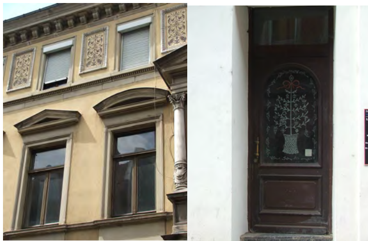
n°6 rue de la Chapelle, détails de modénature et porte d'origine
