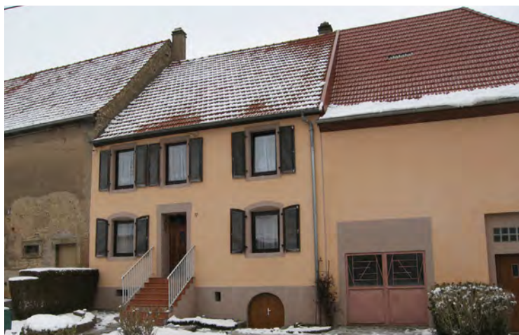
n°17 rue de la Fontaine : les portes de grange ont souvent été modifiées, de même les menuiseries des fenêtres ont souvent été remplacées par des fenêtres à un seul vantail.
