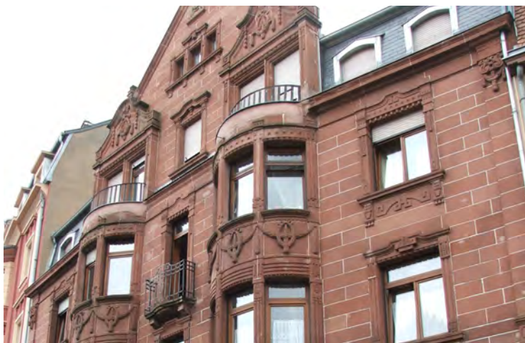
n°2 rue du Parc (1908)
