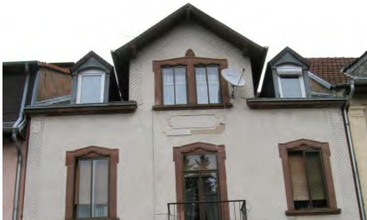
n°35 rue des Muguets : ce type de toiture a été souvent utilisé à Sarreguemines, au cours du XIX e siècle allemand. Le XX e siècle allemand en produira beaucoup moins.
