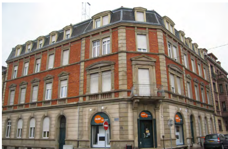
n°35 rue du Maréchal Foch
