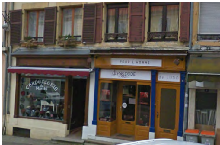
n°8-10 place du Marché : exemple d'une devanture en applique en bois à Sarreguemines (parmi les bâtiments répertoriés) qui est en fait un mélange hybride avec ses poteaux en fonte.
