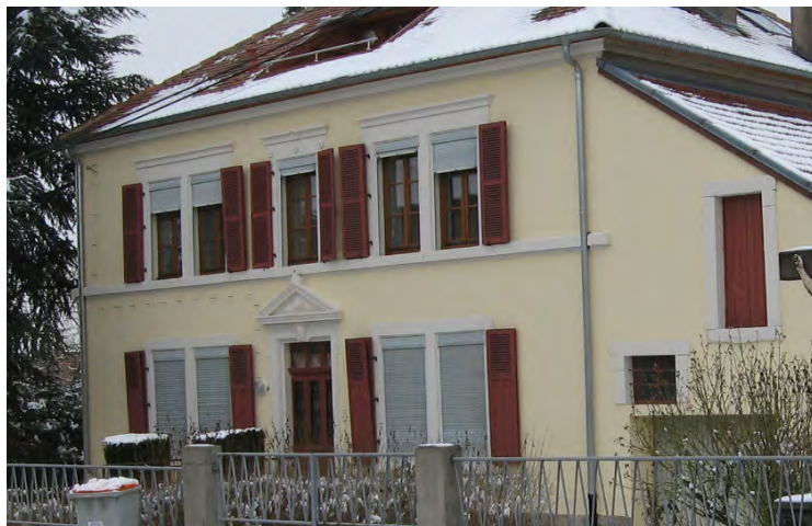
n°162 rue de Felpersviller : les fenêtres en bois divisées en 3 carreaux par vantail respectent le modèle d'origine. Les volets battants sont à persiennes à l'étage et mixtes au RDC.
