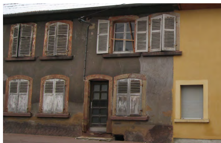
n°9 rue des Romains : les menuiseries d'origine sont les fenêtres à 2 vantaux divisés en 2 ou 3 carreaux par vantail, et les volets battants à persiennes (avec grandes lamelles) et de modèle mixte au rez-de-chaussée.
