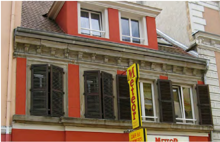
n°13 rue de Verdun : les éléments de modénature en pierre sont : la corniche avec ses modillons, les encadrements des baies avec chambranle, les bandeaux horizontaux délimitant les étages.
