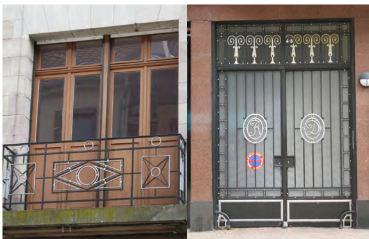
n°4-6 rue Ste-Croix : les menuiseries d'origine en bois devront être conservées de même que les ferronneries de style art-déco. Les volets roulants sont parfaitement intégrés aux dimensions des baies.
