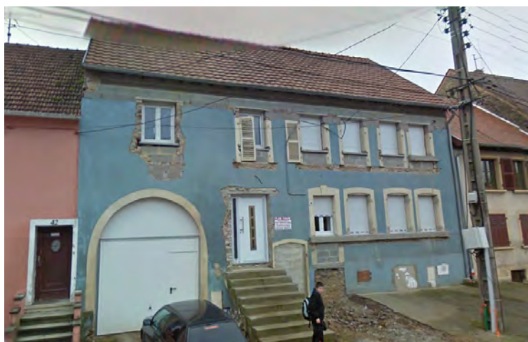
n°40 rue de Bitche : ancienne ferme de taille moyenne avec partie grange transformée en garage et entrée surélevée accessible par un escalier droit (élément récurrent dans les villages autour de Sarreguemines).
