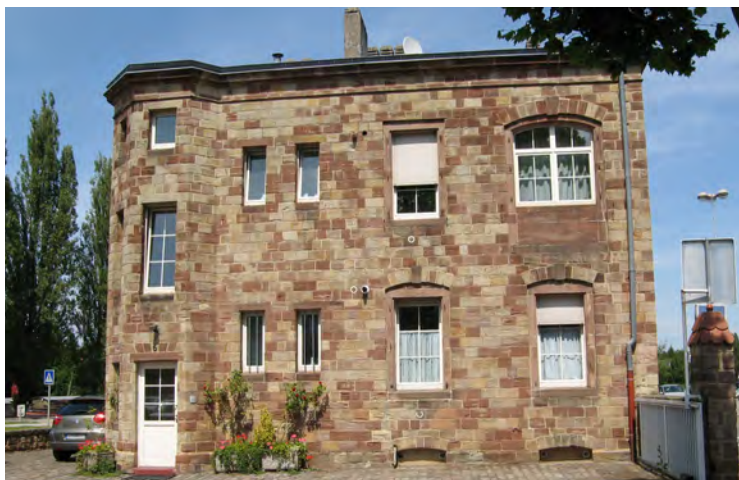
n°6 rue du Bac
