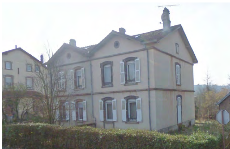
n°6-8 rue Edouard Cazal (Cité des Faïenceries, 1869) : cette maison jumelée est dotée de 2 avant-corps avec pignon en façade avant, les entrées s'effectuant latéralement en pignons.
