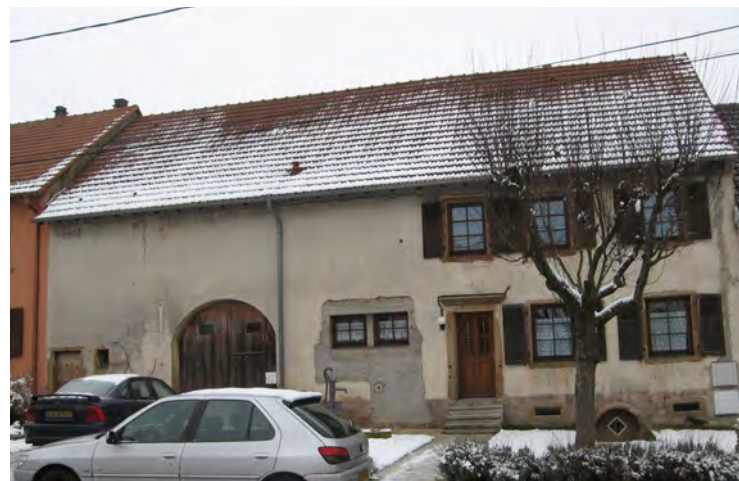
n°6 rue du Groupe Scolaire : ferme de taille moyenne regroupant sous un même toit la partie grange et la partie habitation. La forme cintrée de la porte de grange est encore d'origine.
