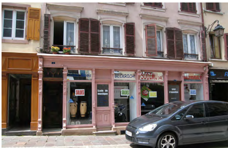
n°7 rue du Marché : plusieurs devantures en applique datant de la fin du XIX e -début XX e siècle, ont été réalisées avec des éléments en fonte. Ces devantures ont généralement conservé leur aspect d'origine sans modification des RDC.
