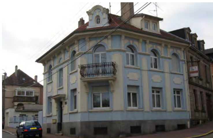
n°2 rue Lamartine : exemple d'une teinte bleu pastel possible, couleurs subordonnées à la composition de la façade.
