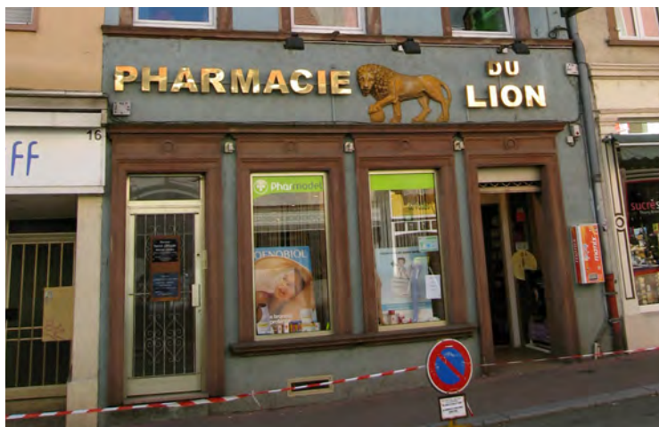
n°14 rue Nationale : il s'agit d'une des rares devantures qui a conservé le rez-de-chaussée d'origine de l'immeuble (bien que les menuiseries aient été changées), avec une porte permettant d'accéder au commerce et l'autre aux étages.
