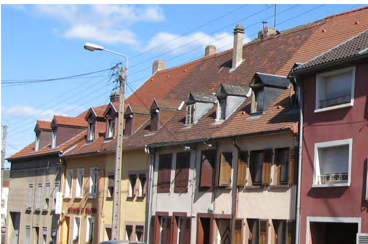
rue de Grosbliederstroff (type A1) : aucun châssis de toit, différents modèles de lucarnes en bâtière (d'origine, du XIX e et XX e siècle) tous alignés dans le tiers bas de la toiture et limités à 2 par pan.
