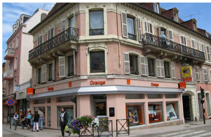
n°1 rue Charles Utzschneider : la plupart du temps, les rez-de-chaussée des immeubles ont été complètement transformés dans la deuxième moitié du XX e siècle.
