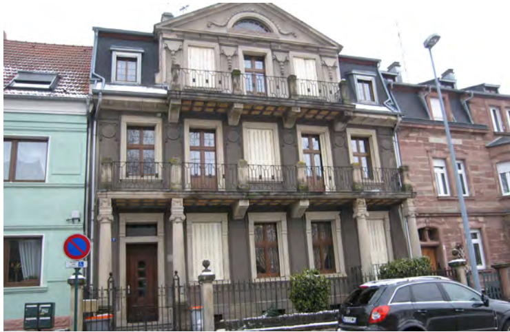
n°3 rue Albert 1 er : une modénature très riche, des balcons soutenus par des corbeaux sculptés en pierre et des colonnes au chapiteau ionique, ordre classique très utilisé dans l'architecture allemande.
