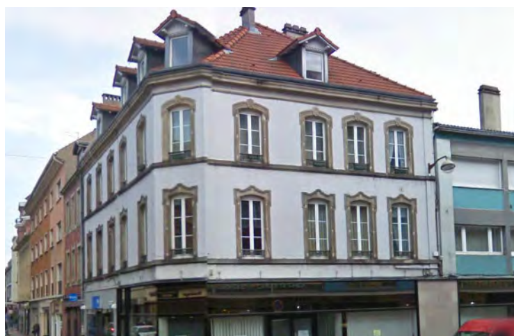
n°5 rue de la Chapelle
