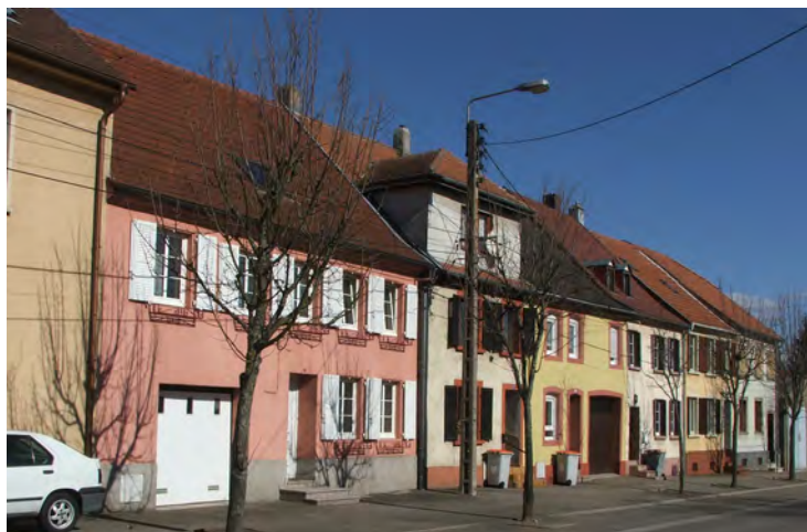
n°10-12-14-16-18 rue d'Ippling : pas de lucarnes en toitures à l'origine, dans les villages alentours.
